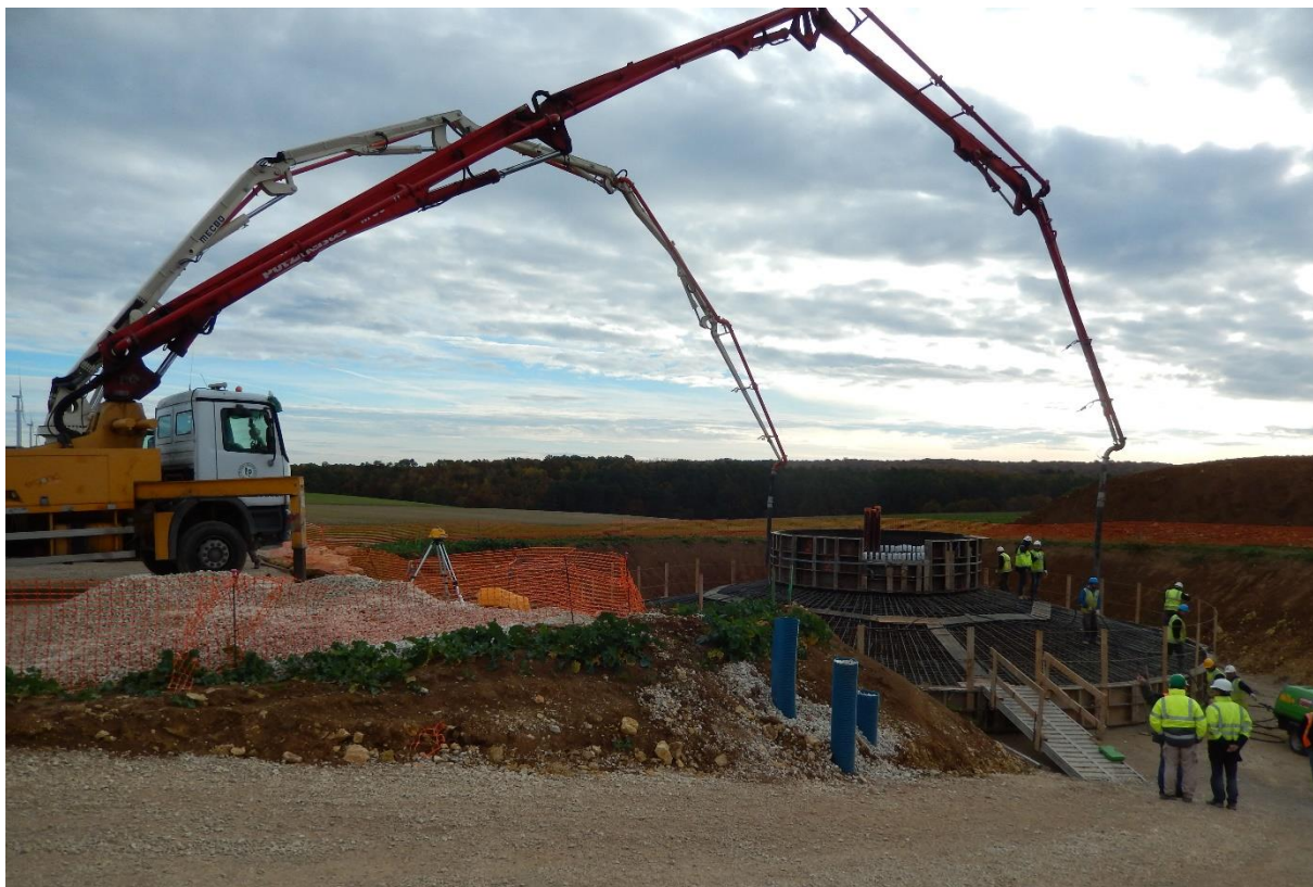
Fondation pendant le coulage du béton
