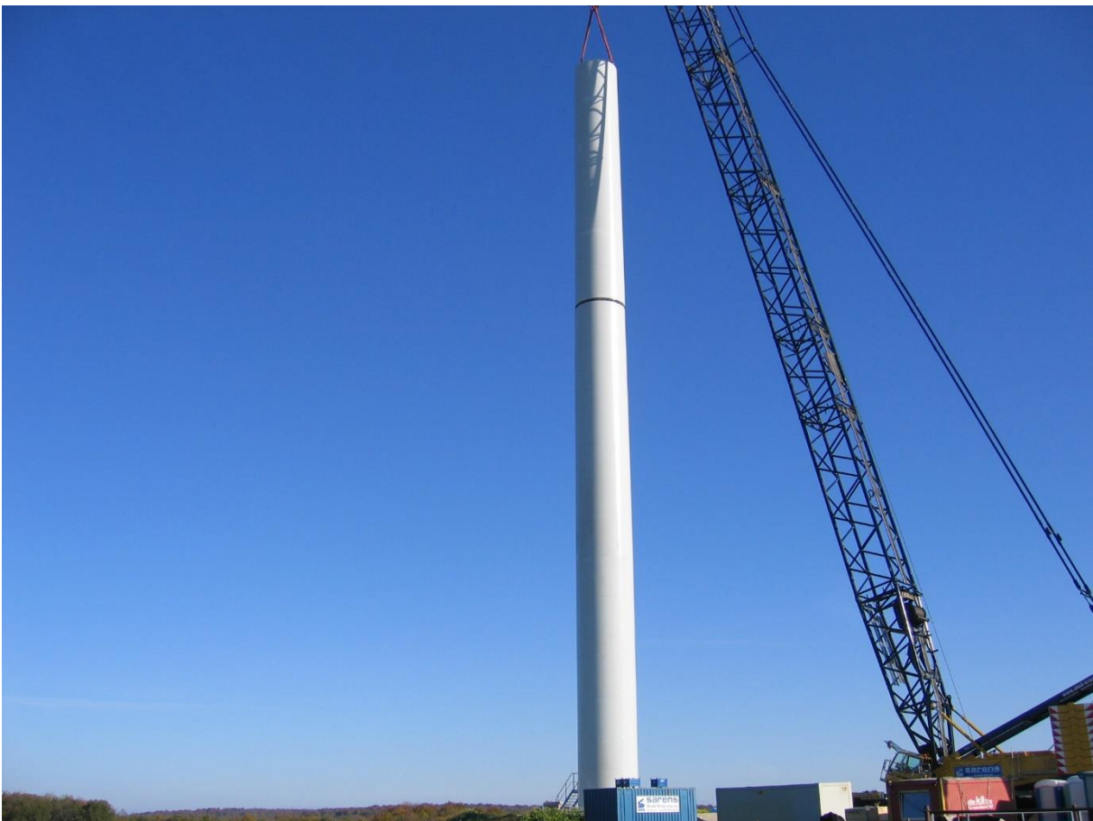
Montage d'une section de mât
