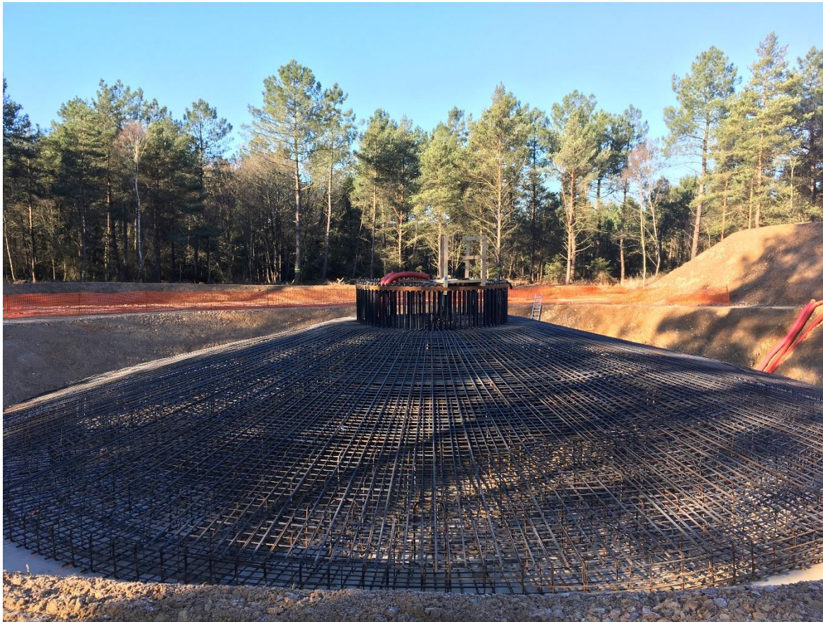
Fondation pendant le coulage du béton
